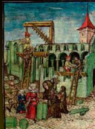
Mönche helfen mit: Bau der Franziskanerkirche in Luzern, 1270
